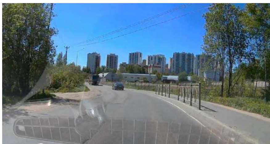
Рисунок 2.7.2.2 – Отсутствует разметка 1.1 согласно требованиям ГОСТ 52289-2019, ул. ш. в Лаврики
