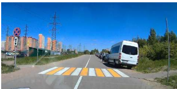
Рисунок 2.7.1.1 – Отсутствуют дорожные знаки 5.19.1(2) согласно требованиям ГОСТ Р 52289-2019, проспект Авиаторов Балтики, МО «Муринское городское поселение»
