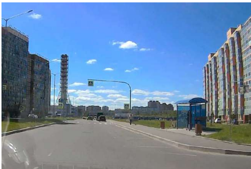
Рисунок 2.5.1.2 – Остановочный пункт на Воронцовском бульваре (отсутствует заездной карман)
