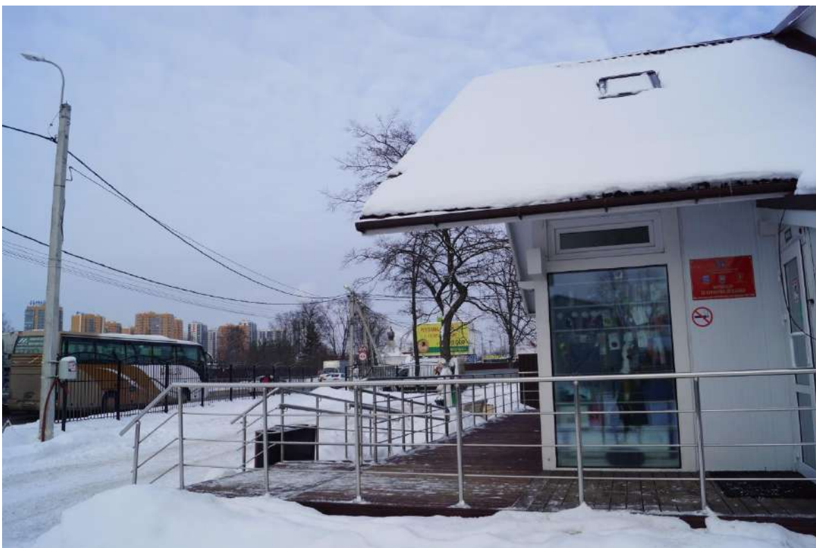
Видовая точка ВТ 8 Вид на часовню с юго-запада с ул. Центральной
