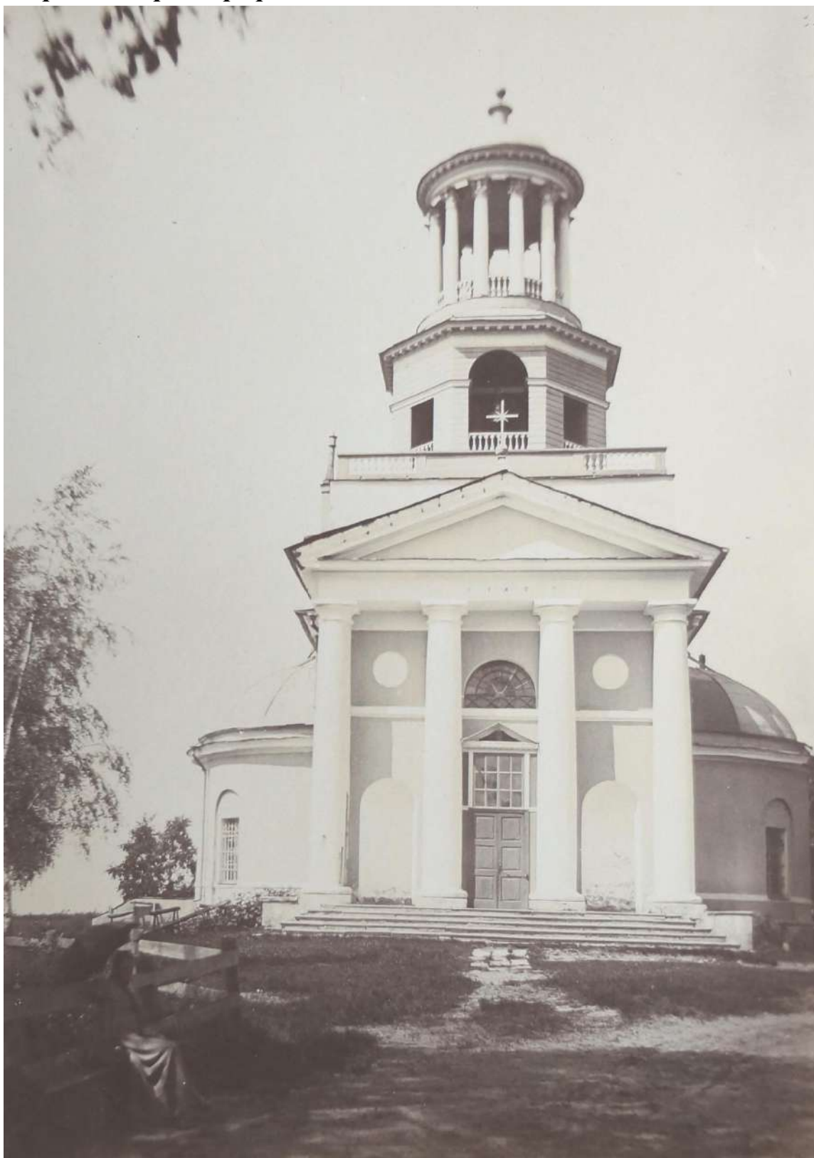
Рис. 4.1. Село Мурино (близ С. Петербурга) Боковой фасад церкви Екатерины, 1894 г.
