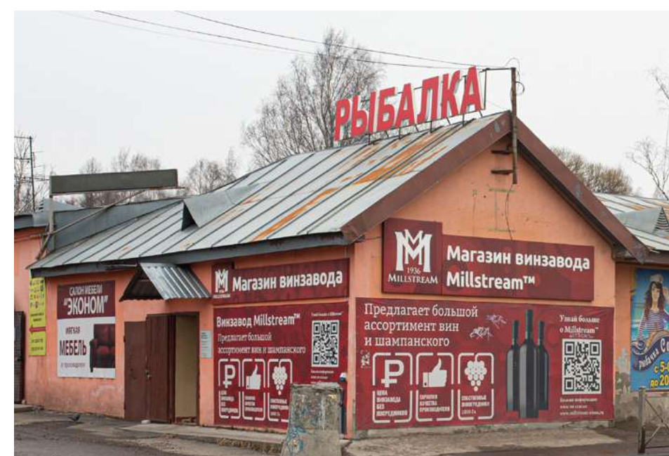
Крышная установка установлена на здании высотой менее 9 м; вывеска на баннерной ткани.
