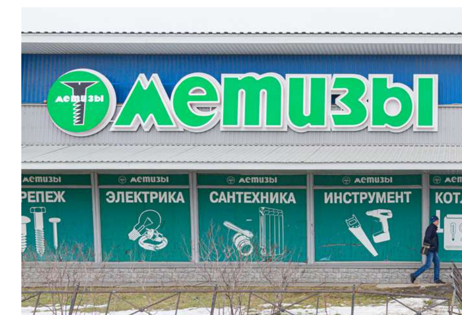
Полное перекрытие светопрозрачных конструкций; вывеска не соответствует разрешенным размерам.
