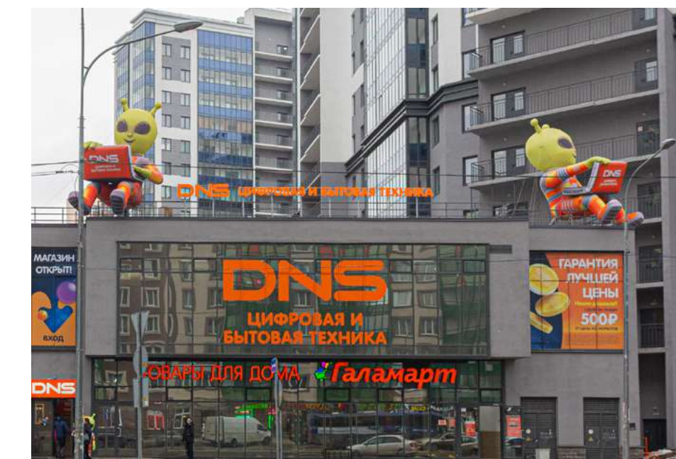
Вывески не соответствуют разрешенным размерам; размещение объектов на крыше.
