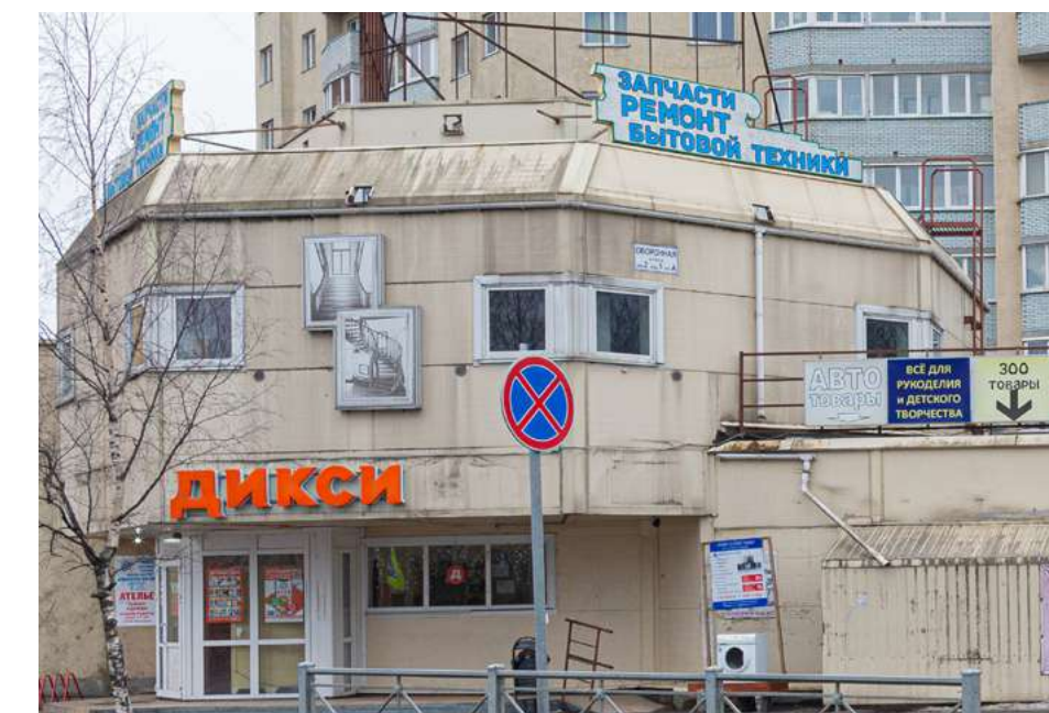
Крышная установка установлена на здании высотой менее 9 м.
