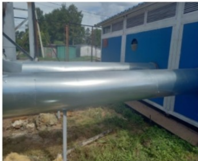
После проведения ремонта
